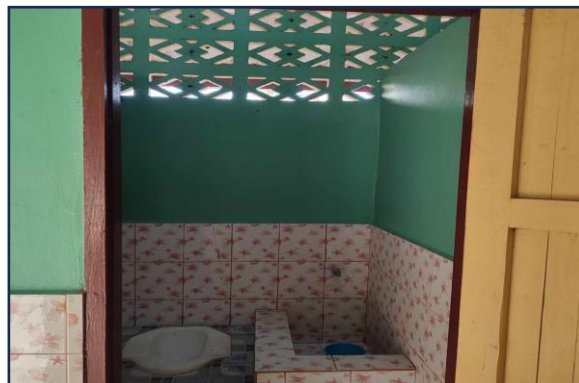
สภาพภายในห้องน้ำ
